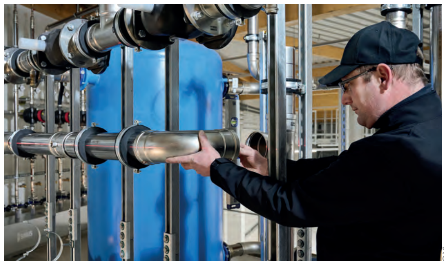
Entlang der Laser-Linie richtet André Kropp die komplette Installation aus: „Nach dem Verpressen soll – und ist – so alles schnurgerade!“
