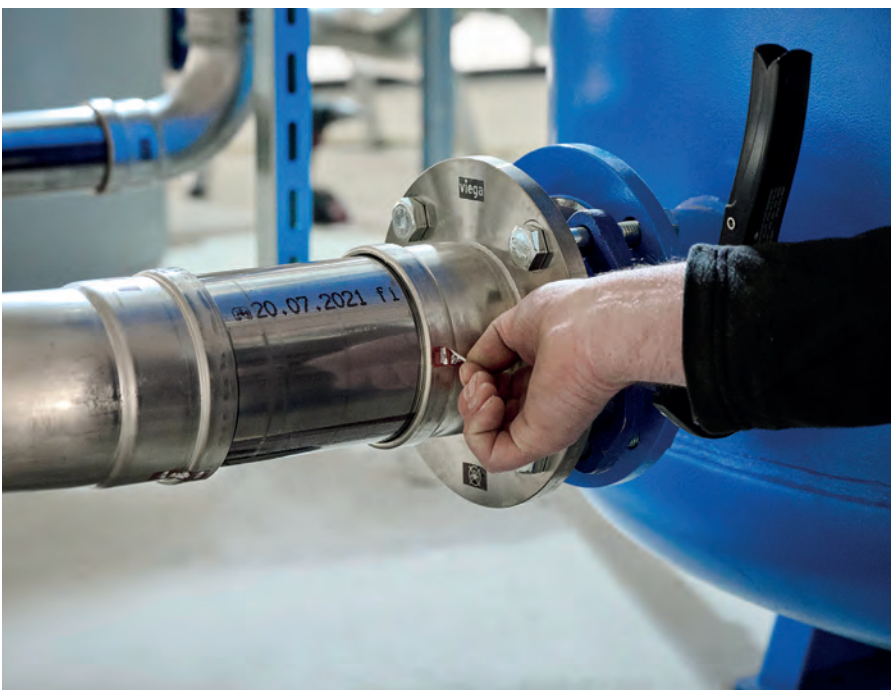
! Nach dem Verpressen – hier eines „Temponox“-Flansches – wird händisch ein kleiner Aufkleber entfernt. So ist die schnelle und sichere Verpressung auf den ersten Blick erkennbar.
