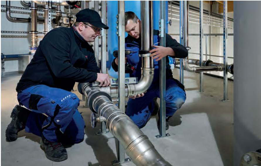
! Bei der Installation des Edelstahl-Rohrleitungssystems „Temponox“.
